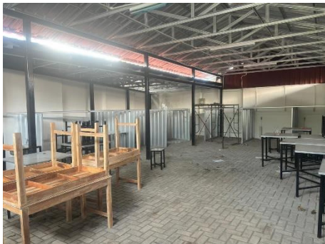
Kantin (Dalam Proses Pembangunan)
